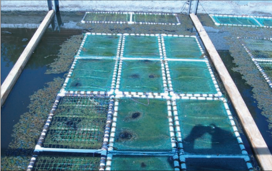
Рис. 1. Встановлені плотики із полімерним волокнистим носієм в експериментальній секції ЛОС-54
